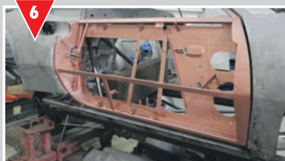
Remplacement du panneau de porte droite et traitement anticorrosion de sa structure.
